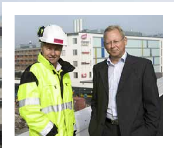
Jukka Posti (oik.) käy tutustumassa juuri valmistuneisiin Myllypuron osiin rakennuspäällikkö Jorma Kajanderin johtamassa.
