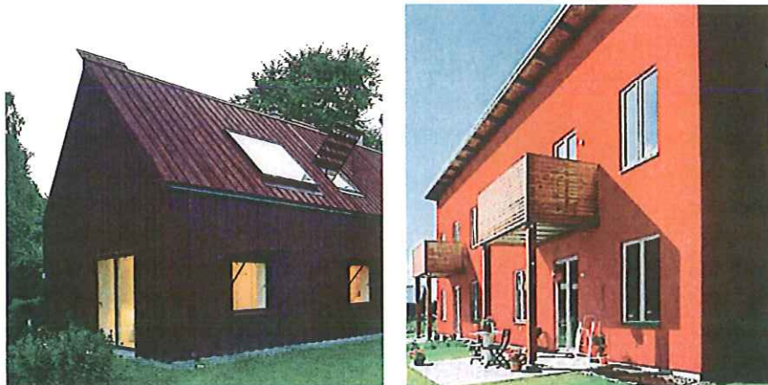
Esimerkkejä omakotitalojen julkisivuista. Julkisivut ovat yksinkertaisia ja koristeluna on käytetty lähinnä ikkunanpuitteiden värejä ja ovia.
